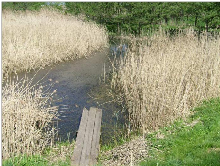
Abb. 21: Regenrückhaltebecken 96W8 "Aspichring" am Aspichbach
