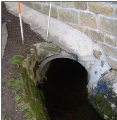
Abb. 30: Einlauf Verrohrung unter der Alten Schmiede
