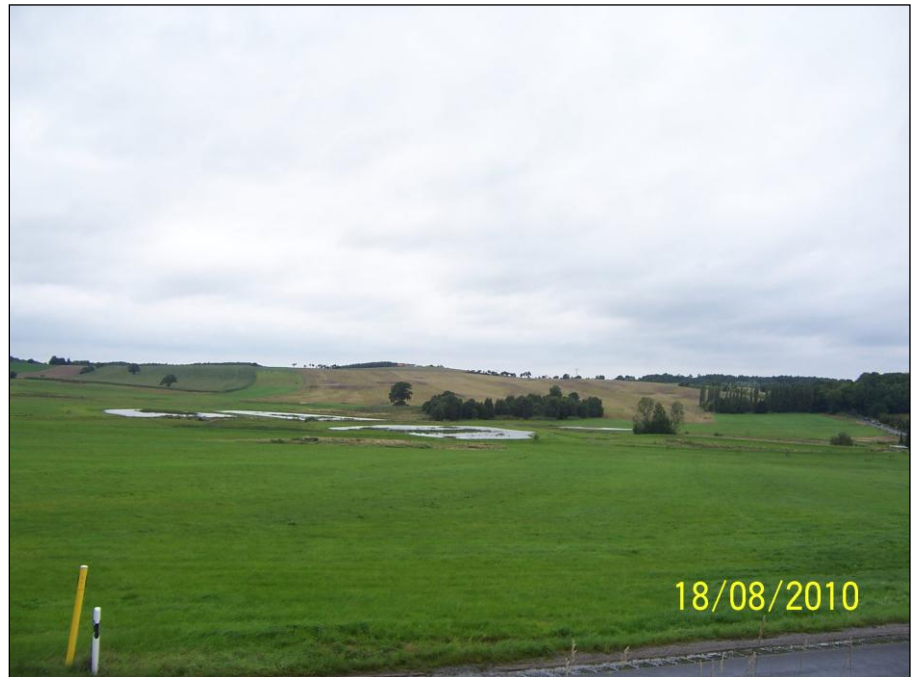
Abb. 19: Eingestautes Hochwasserrückhaltebecken Schullwitzbach (Flutmulden)
