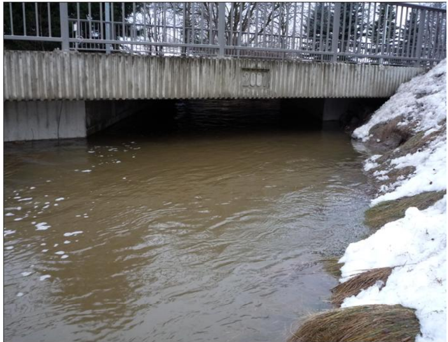
Abb. 31: Brücke Dittersbacher Straße, Februar 2009
