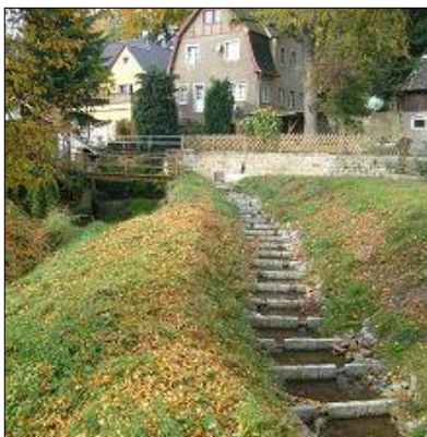
Abb. 6: Fischtreppe im Schullwitzbach neben dem Eschdorfer Teich
