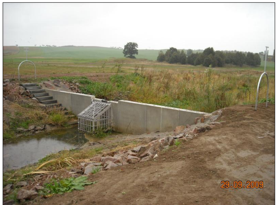
Abb. 20: Hochwasserrückhaltebecken Schullwitzbach (Flutmulden), Drosselbauwerk
